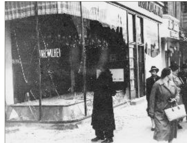
In der „Reichs- kristallnacht“ wurden in Wien unzählige Ge- schäfte zerstört und geplündert. Das Uhrma- chergeschäft der Wein- bachs blieb ver- schont, weil sich Nachbarn zum Schutz vor dem Laden aufgestellt hatten.
